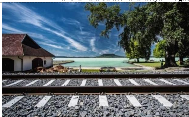
Fonyód-Bélatelep vasútállomás, felújított vasútpálya (fotó: NIF Zrt.)
