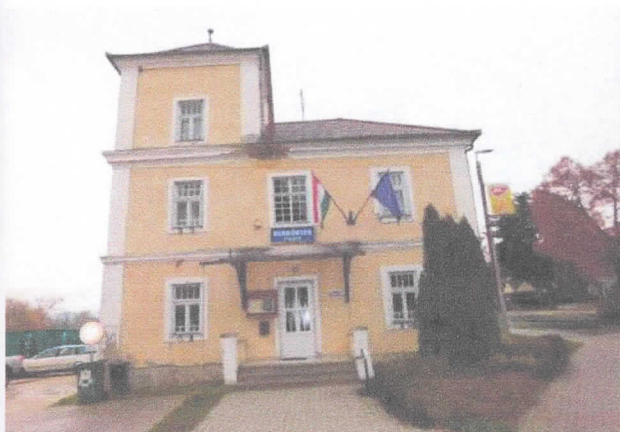
az épület bejárata az ÉNy-i homlokzaton
