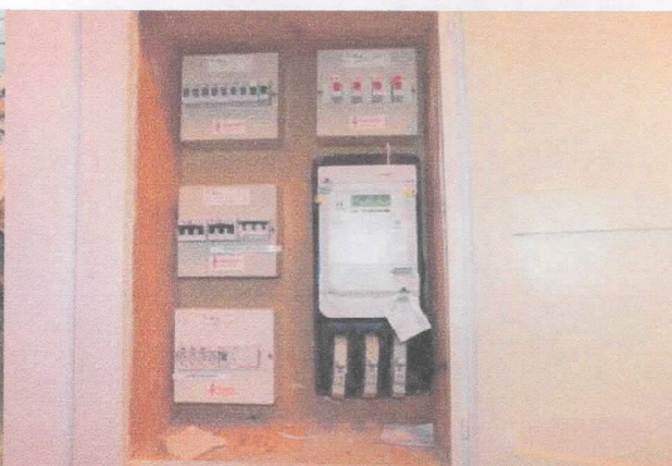
árammérő, biztosíték táblákkal
