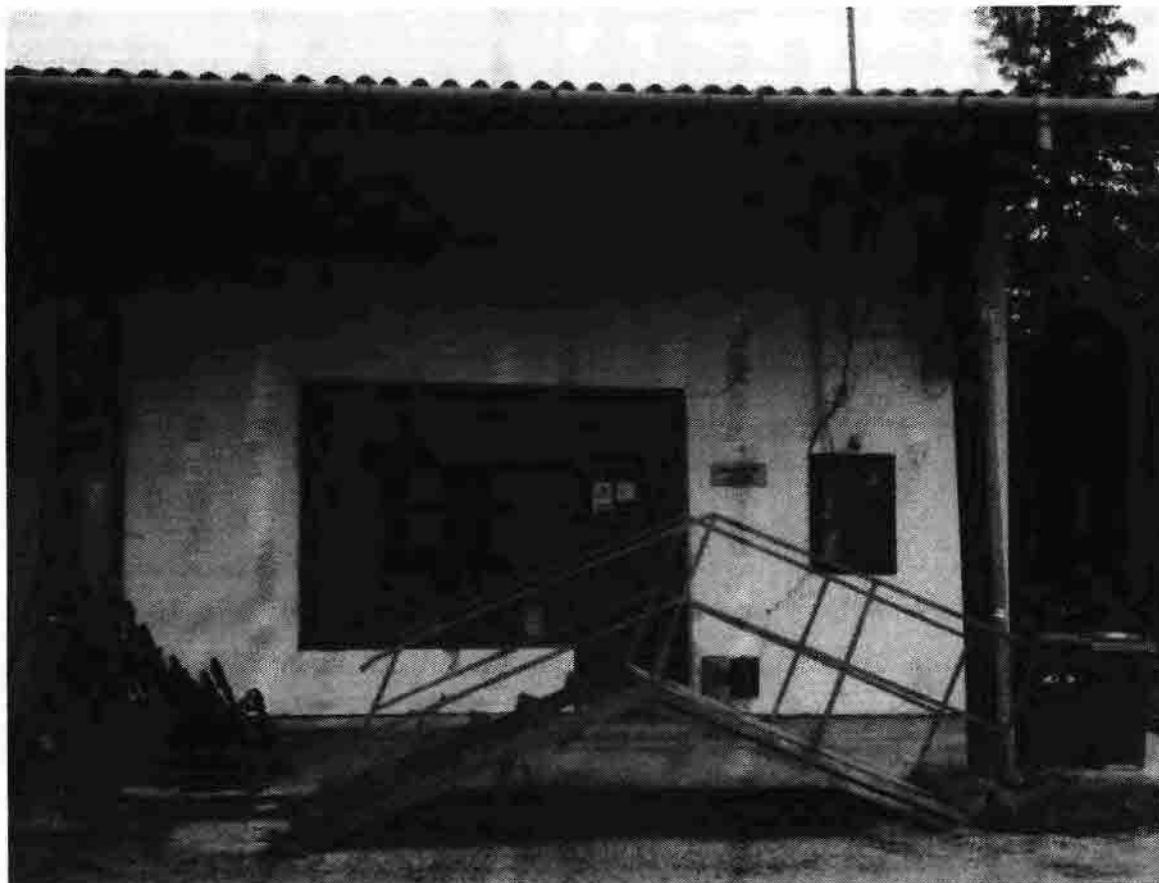
3.) Fotó Az épület Dél-nyugati főfalán látható károsodások.
