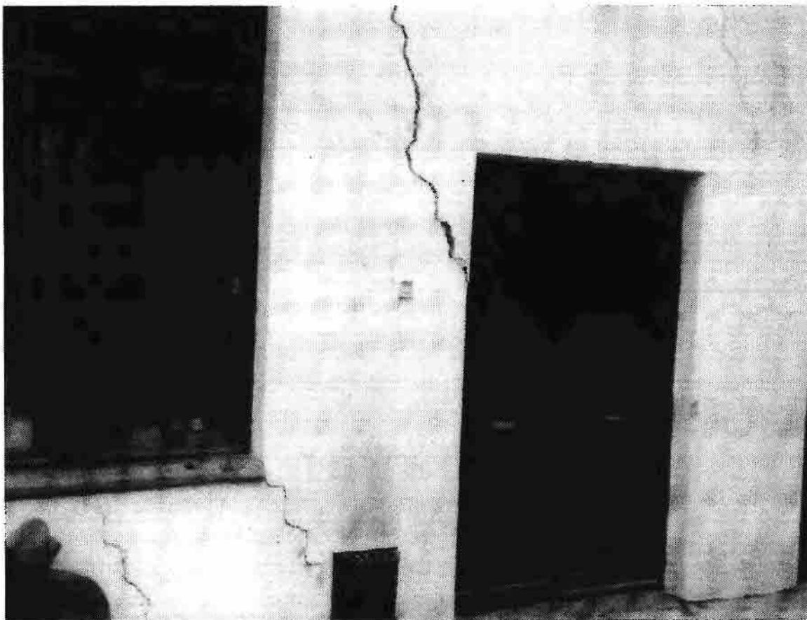
2. Fotó Az épület végfalán látható károsodások.
