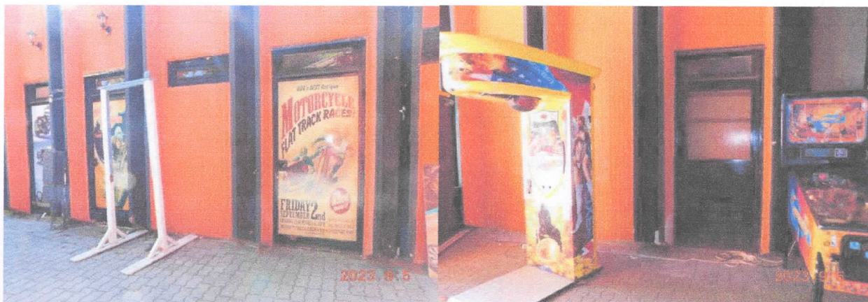
az épület - nem használt - kijáratai a ÉK-i oldalon
