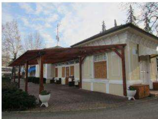
A „Csigaház” északi homlokzata elé épített faszerkezetű teraszfedés – 2013.
